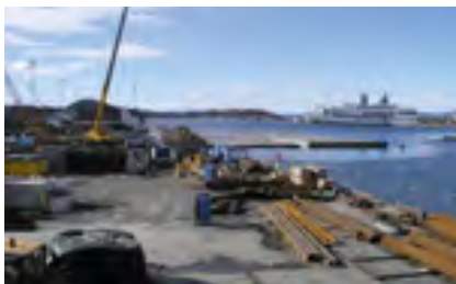
Bjørvikatunnel I Oslo, Norwegen
