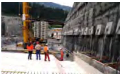
Tunnel Küblis, Schweiz
