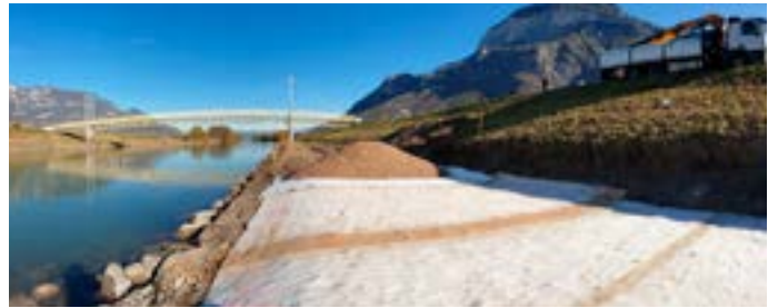
Uferbereiche von Gewässern sind ständiger geometrischer Veränderung unterworfen, wenn man natürliche Prozesse zulässt. Gut, wenn sich die eingebauten Bauprodukte wie die Naue GreenLine daran anpassen.
